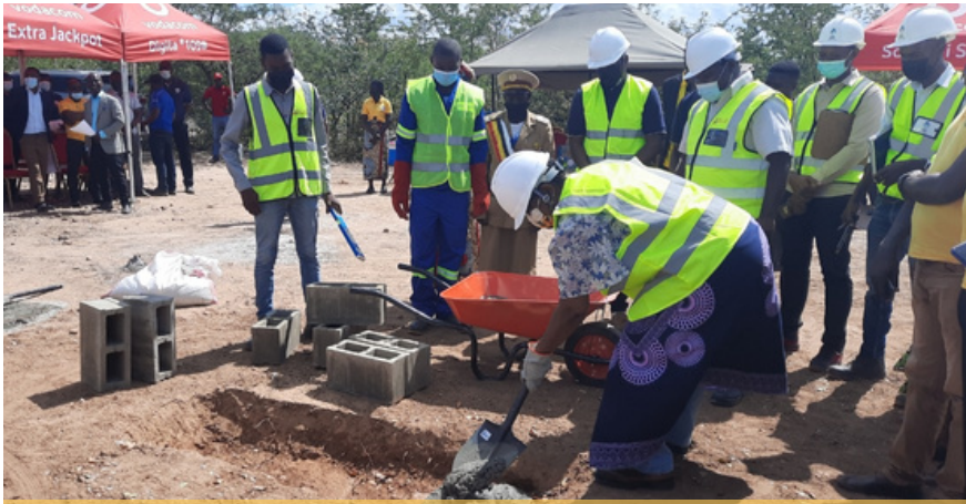
Reitora da UniPúnguè, Emília Nhalevilo, implantando a primeira pedra para a construção do muro de vedação do Campus de M'páduè
